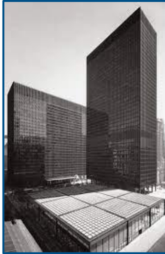
Federal Center Chicago, IL
